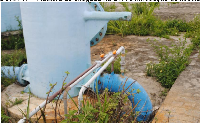
FIGURA 17 – Adutora de chegada na ETA e introdução do floculante.
