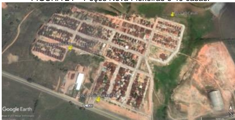
FIGURA 24 – Poços Nova Flexeiras e 40 casas.
