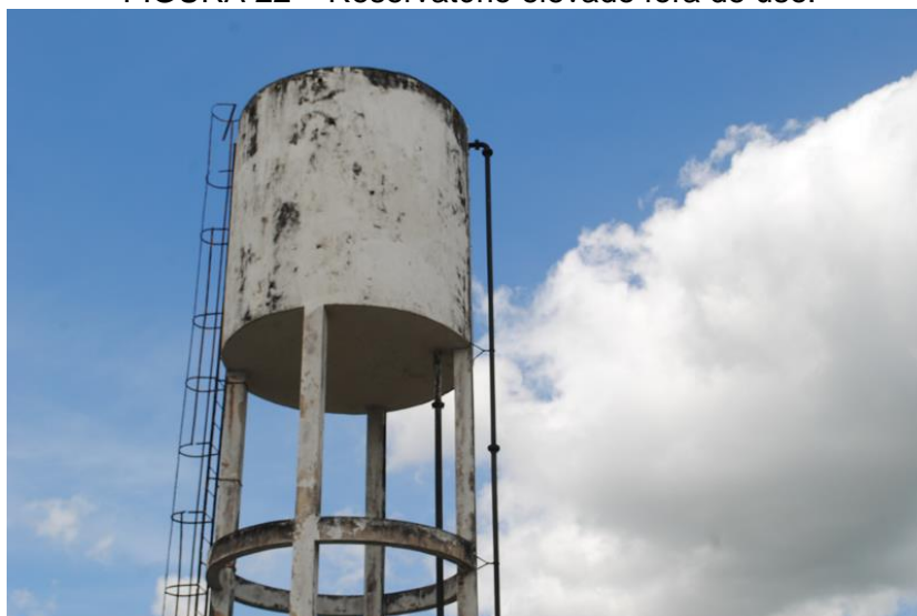
FIGURA 22 – Reservatório elevado fora de uso.
